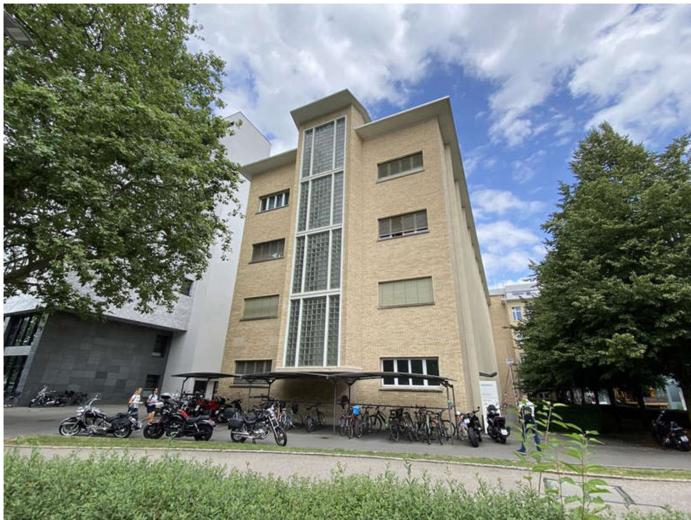
Hier baut die Credit Suisse 60 neue Wohnungen. (Bild: wia)
