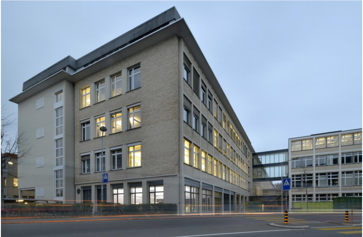
Abb. 7: Denkmalgeschütztes Backsteinhaus am Zählerweg, in der Mitte die Zwischenverbindung zur Shedhalle. Blick von der Nordstrasse Richtung Süden (Quelle: leistungsfotografie.ch)
