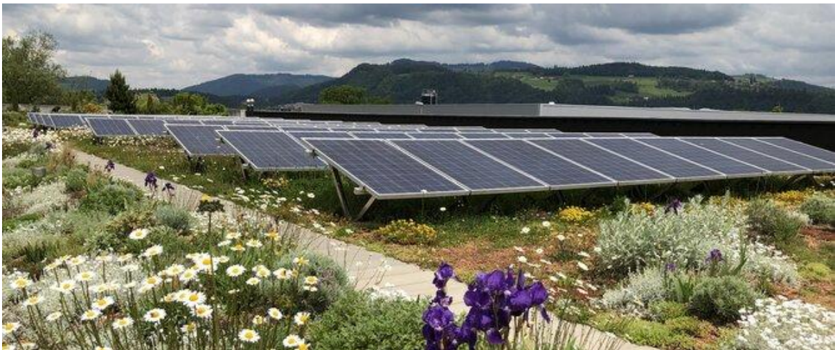
Abb. 30: Dachbegrünung in Kombination mit PV-Anlage (Quelle: Bauenschweiz)
