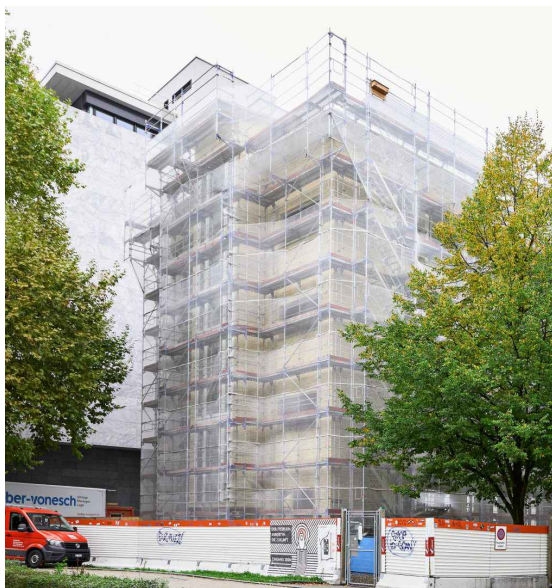
Das Bestandsgebäude am Zählerweg 3 bis 9 wird für Wohnungen und Dienstleistungen umgebaut.
