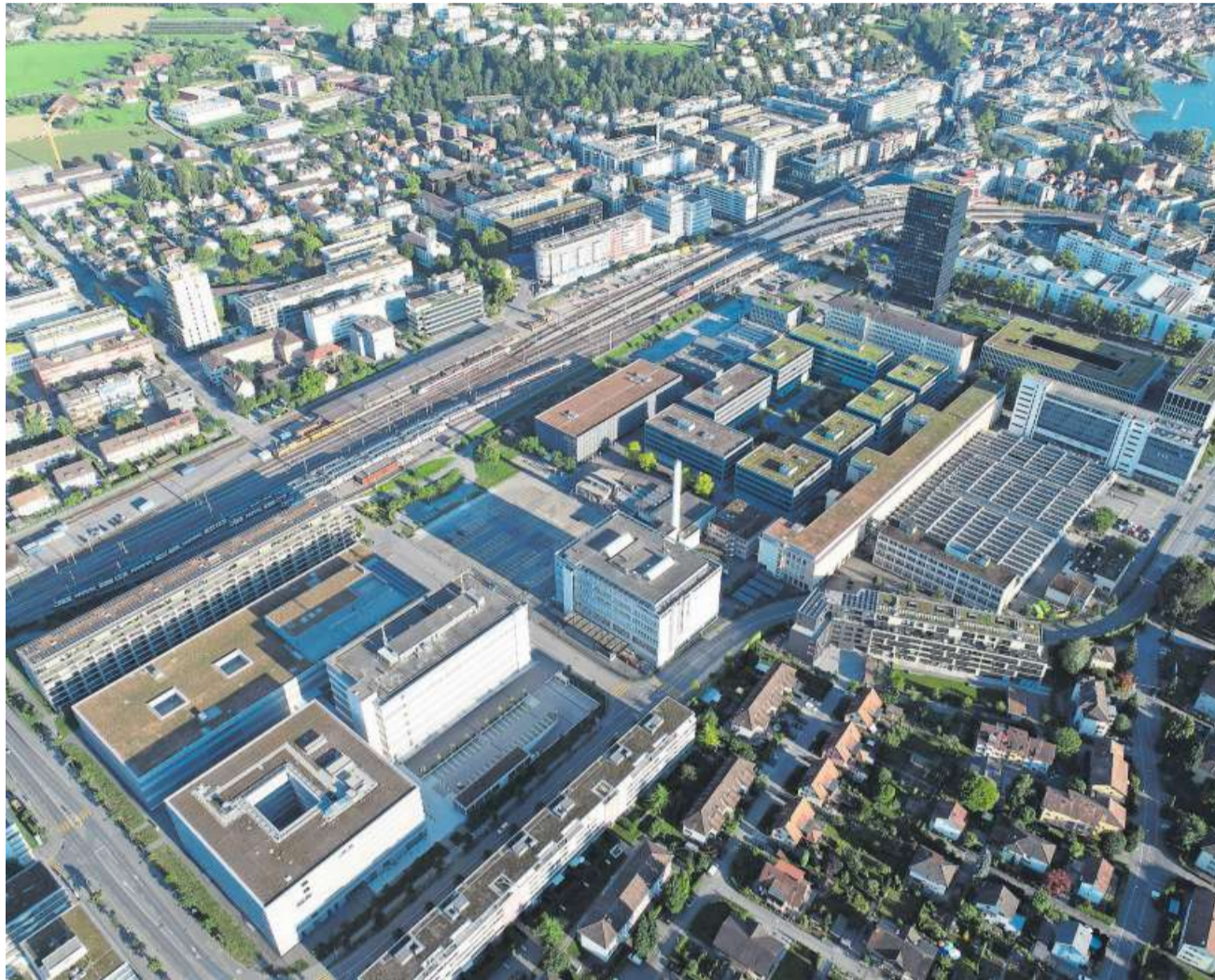
Blick über das Areal der Landis & Gyr in der Stadt Zug.
